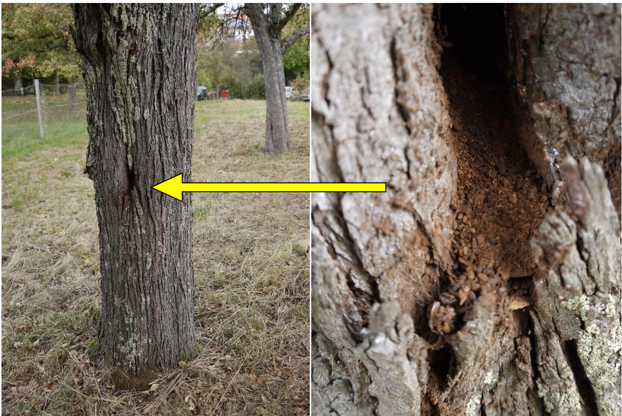
Abb. 12: Potenzieller Habitatbaum für holzbewohnende Käfer. Kleine Spalte mit Kotpillen und Mulm.
